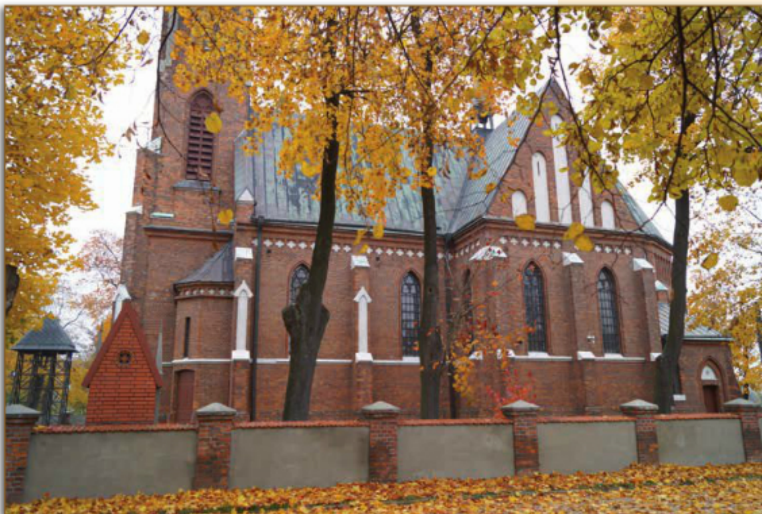
Kościół -widok od strony północnej
